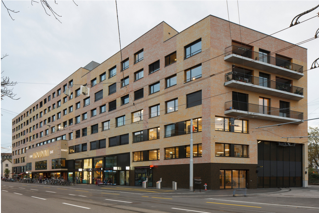
Figura 19. Vista general del conjunto, planta baja comercial, primer y segundo nivel de oficinas y servicios, acceso al depósito de tranvía municipal, Cooperativa Kalkbrite, Zúrich
