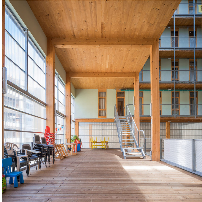
Figura 28. Galería comunitaria y corredor climático en el edificio cooperativo La Borda, Barcelona
